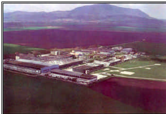
Fig. 29. Noul IAR – vedere aeriana
