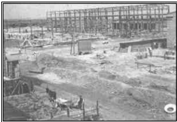
Fig. 7. Uzina IAR în constructie
