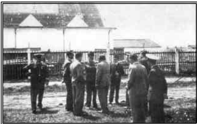
Fig. 13. Stabilirea locului de amplasare a hangarului din pâna pentru aeroclub (1935)
