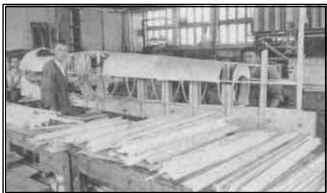
Fig. 18. Atelierul de construire a carlingilor (1936)
